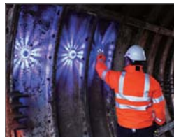
작업 안전성 증가 야간, 터널 작업 활용 가능
